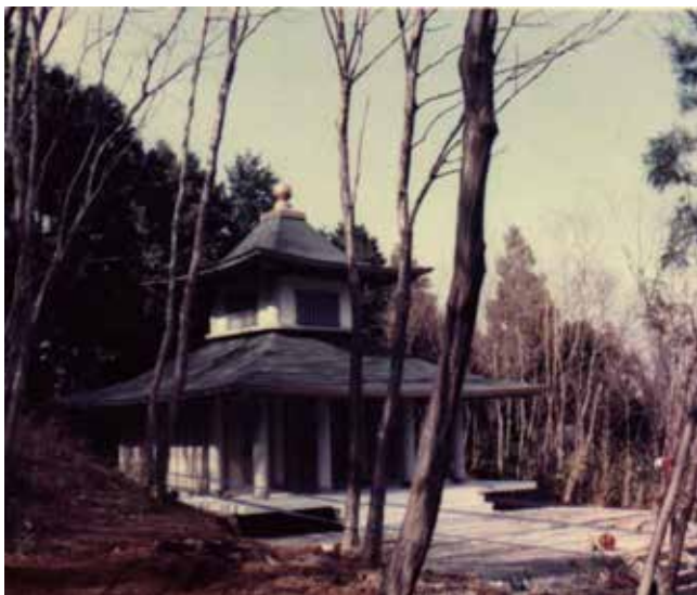
厚木市慰霊堂 RC造 1F 延35.00㎡ 厚木市飯山 昭和48年
