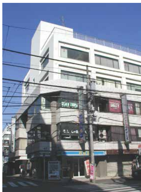
中三ビル RC造 5F 延1,949.341㎡ 厚木市中町 昭和57年
