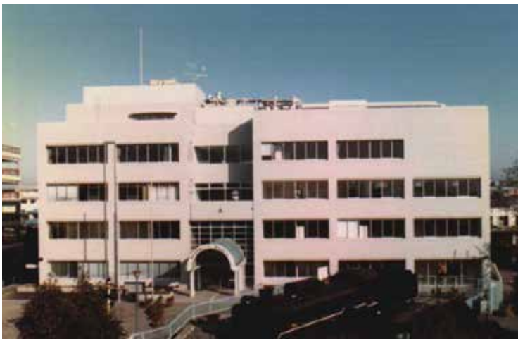
厚木保健センター・婦人会館 RC造 4F 延3,090.10㎡ 厚木市中町 昭和55年
