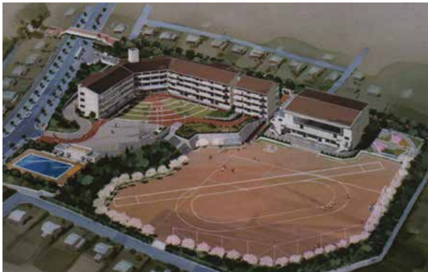
森の里小学校 RC造 4F 延7,533.00㎡ 厚木市小野 昭和58年
