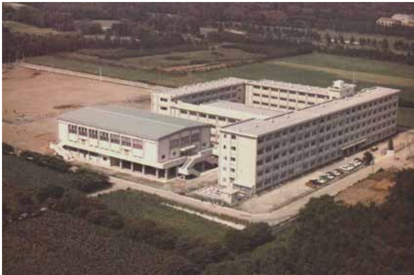
県立麻溝台高校 RC造 5F 延11,852.945㎡ 相模原市麻溝台 昭和48年
