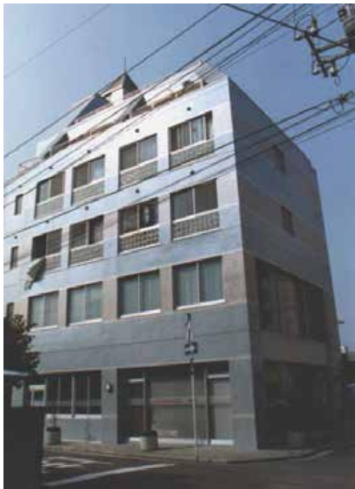
Y・Iビル RC造 6F 延638.01㎡ 厚木市旭町 平成2年
