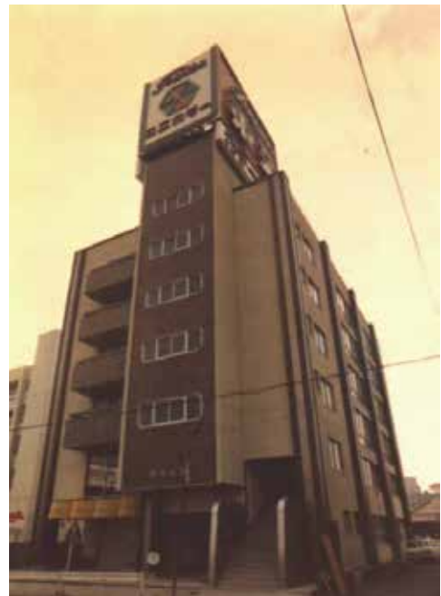
静本ビル RC造 6F 延3,159㎡ 厚木市中町 昭和40年
