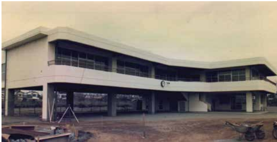
中津南保育園 RC造 2F 延843.53㎡ 愛川町中津 昭和52年
