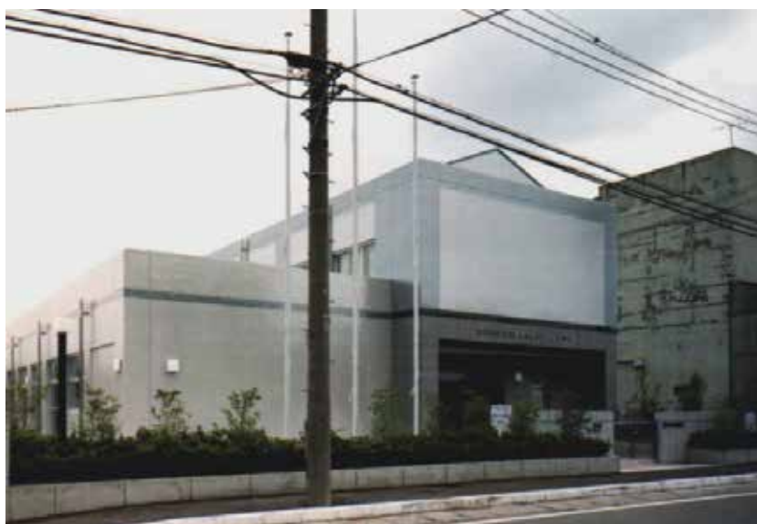
小松原住区学習供用施設 RC造 2F 延885.448㎡ 座間市小松原 平成2年
