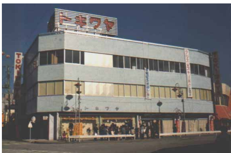
トキワビル RC造 3F 延1,175.405㎡ 厚木市中町 昭和42年
