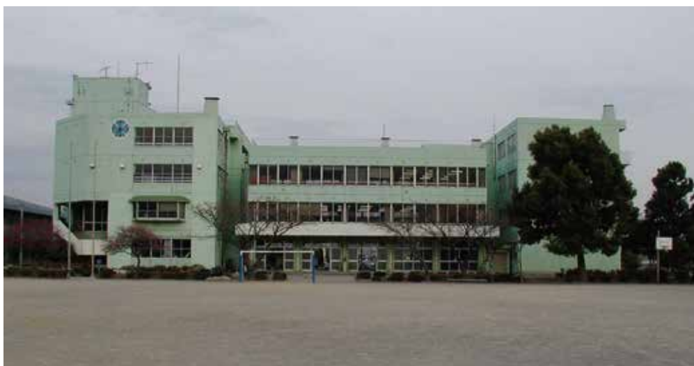
妻田小学校 RC造 4F 延5,400.195㎡ 厚木市妻田 昭和50年
