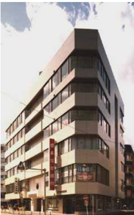
厚木センタービル SRC造 6F, B1F 延2,916㎡ 厚木市中町 昭和56年
