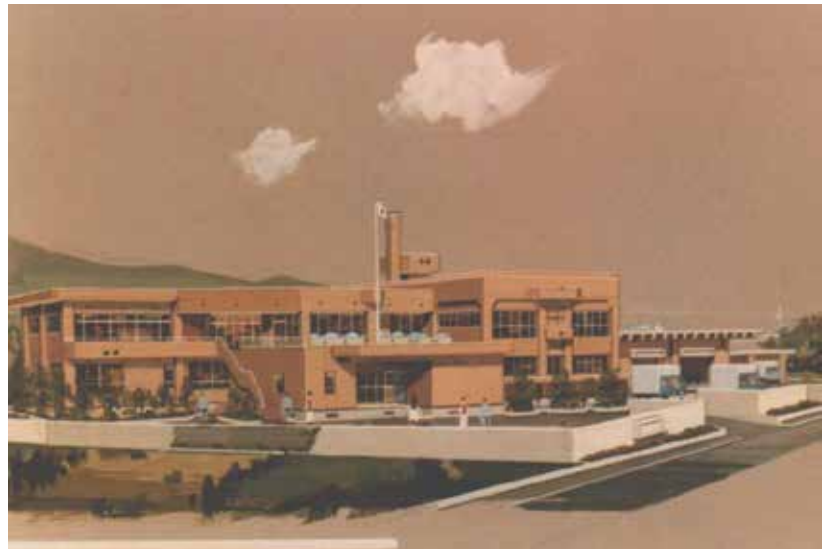
南部給食センター RC造 2F 延1,711.42㎡ 厚木市船子 昭和53年
