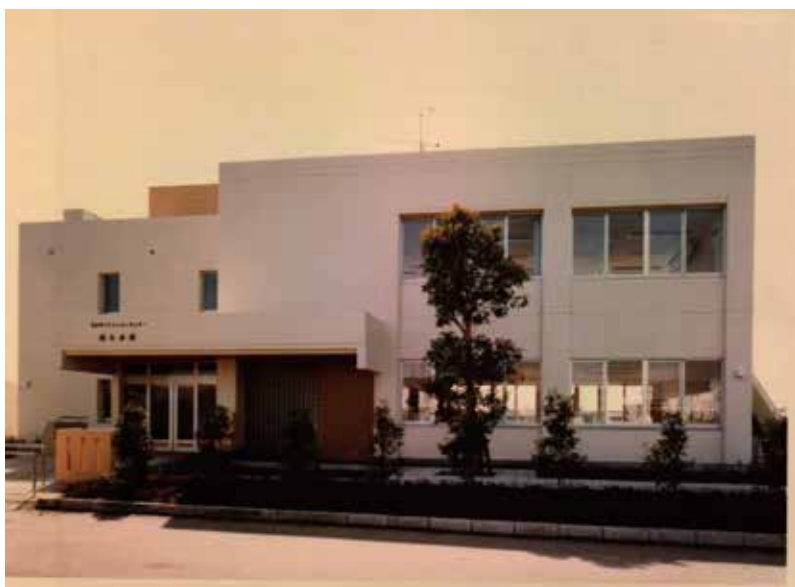
桜丘地区学習等供用施設 RC造 2F 延527.63㎡ 大和市上和田 昭和57年
