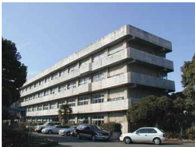
厚木中学校 RC造 4F 延6,835.00㎡ 厚木市水引 昭和49年
