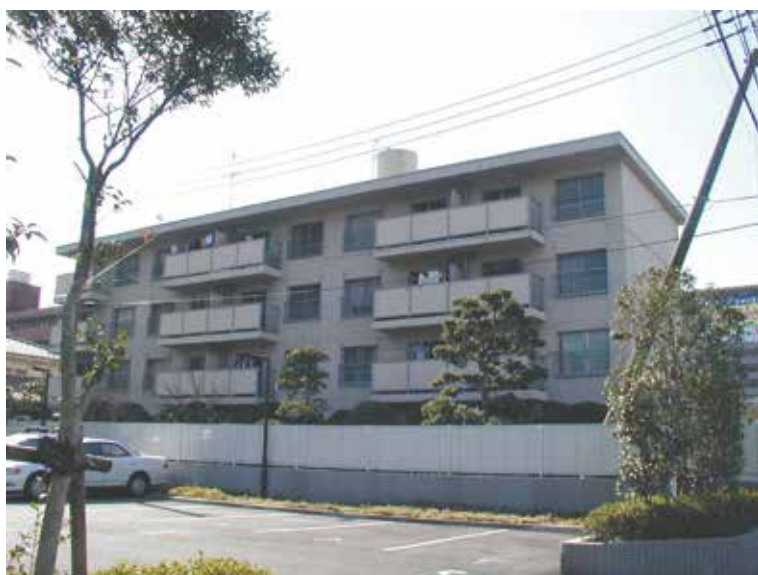
静厚荘 RC造 4F 延858.304㎡ 厚木市栄町 昭和44年
