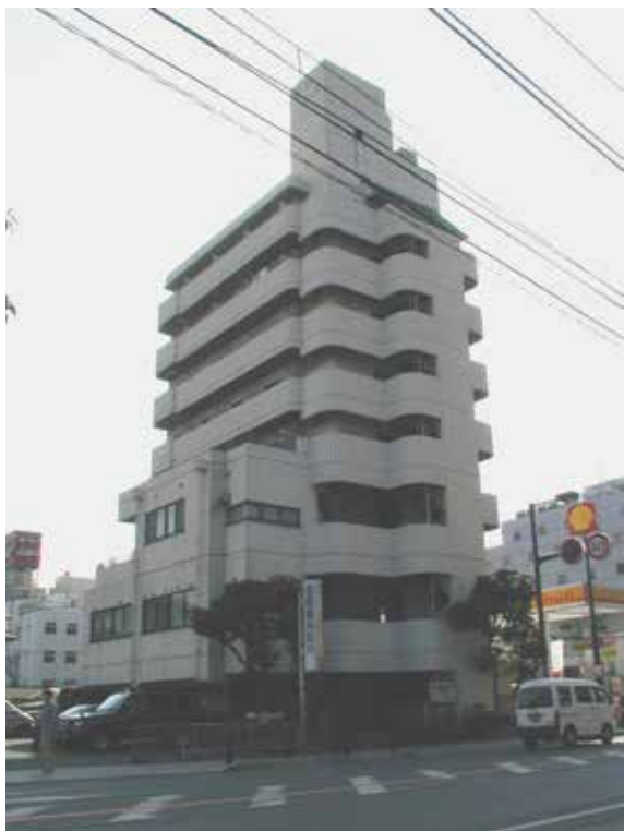
AIDAビル SRC造 8F 延967.03㎡ 厚木市中町 昭和57年
